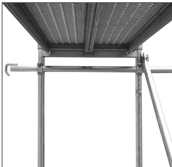
Rys. 1. Sposób zamocowania łącznika kotwiącego
